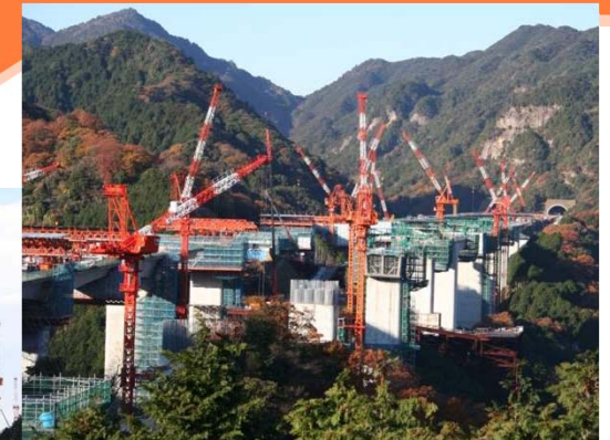
複数の張出し架設ワーゲンによる施工
