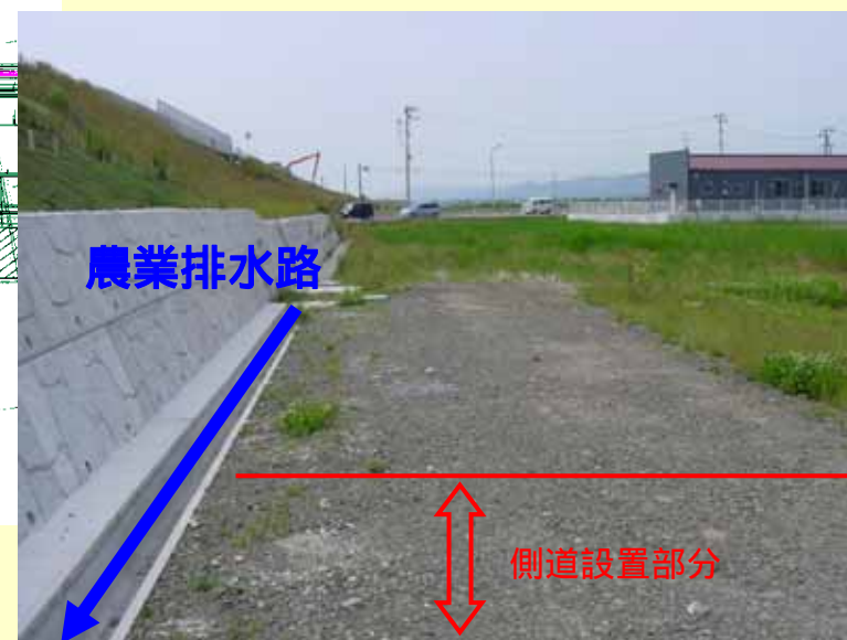
写真 側道の設置状況
