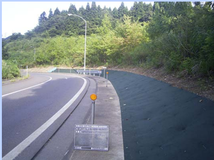
マルチングシート施工例
