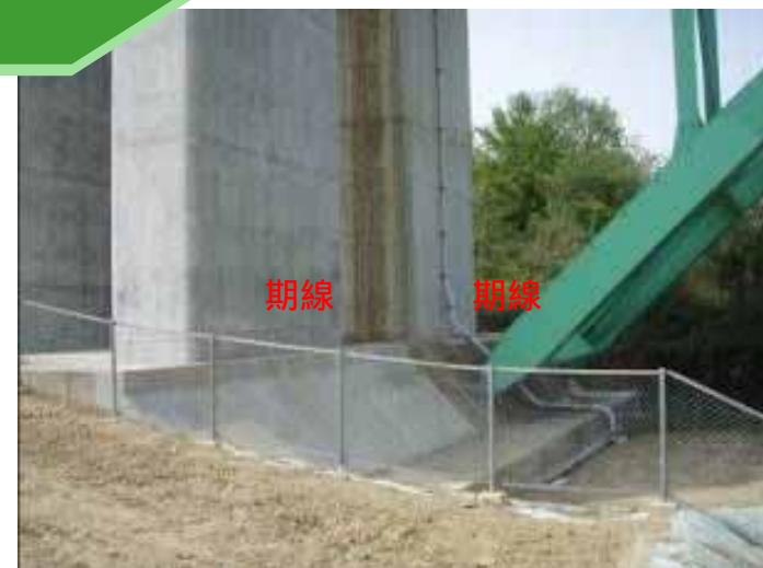
P2橋脚アーチアバット
