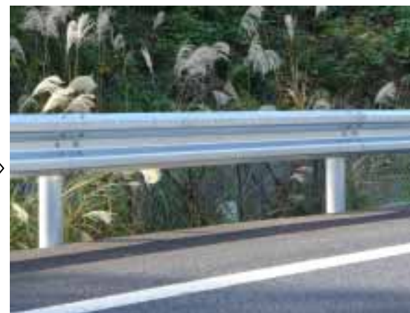
設置 現場へ運搬後、設置
