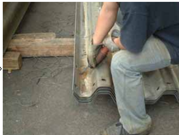
ガードレール清掃 部材の清掃及び研掃を行う
