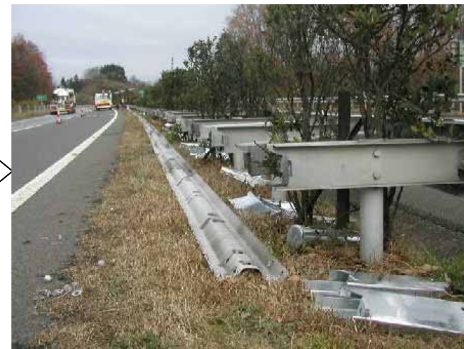
既設レール、ブラケット撤去
