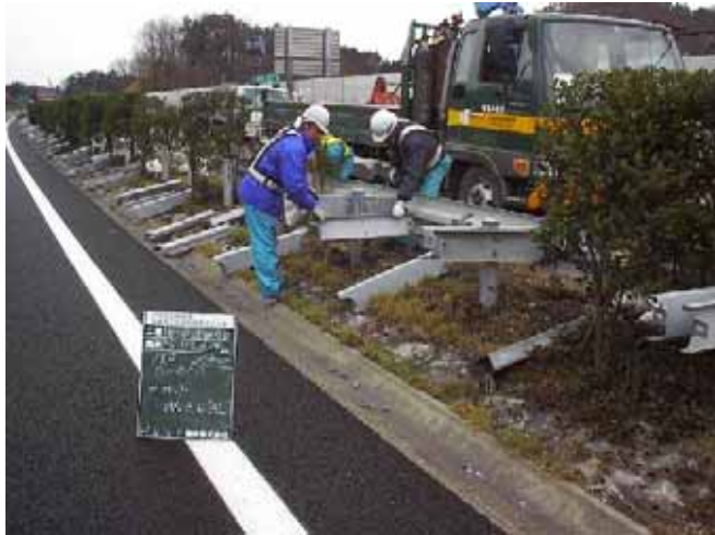
既設レール、ブラケットの撤去
