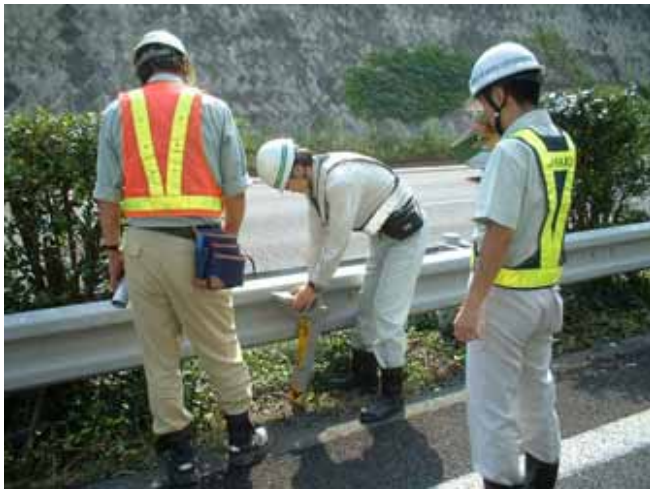
光ケーブルの探査
