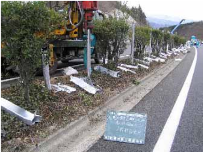
新材支柱の打込み
