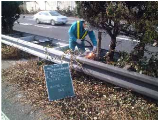
既設支柱頭部20mm切断
