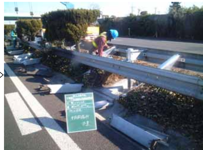
新材ブラケット、既設レール設置
