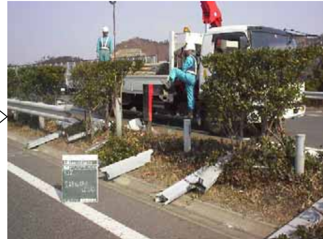
既設支柱の引抜き
