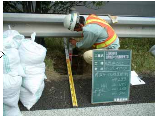
試掘による光ケーブルの位置確認
