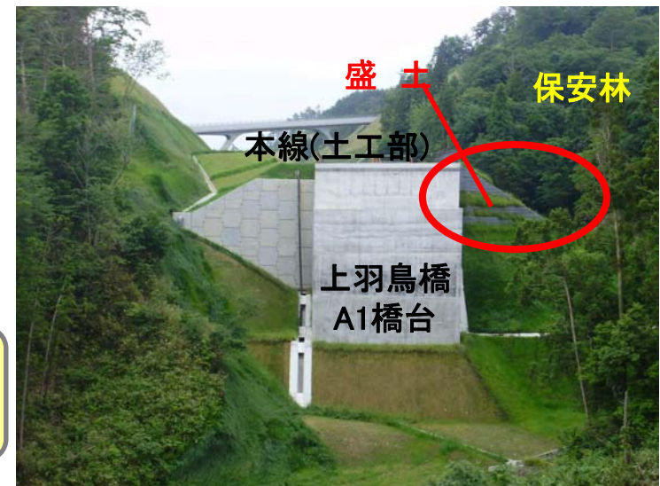
施工後(上羽鳥橋側より)
