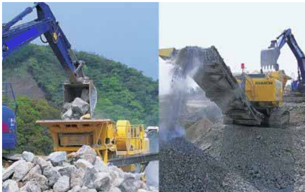
自走式破碎機によるクラッシング作業状況
