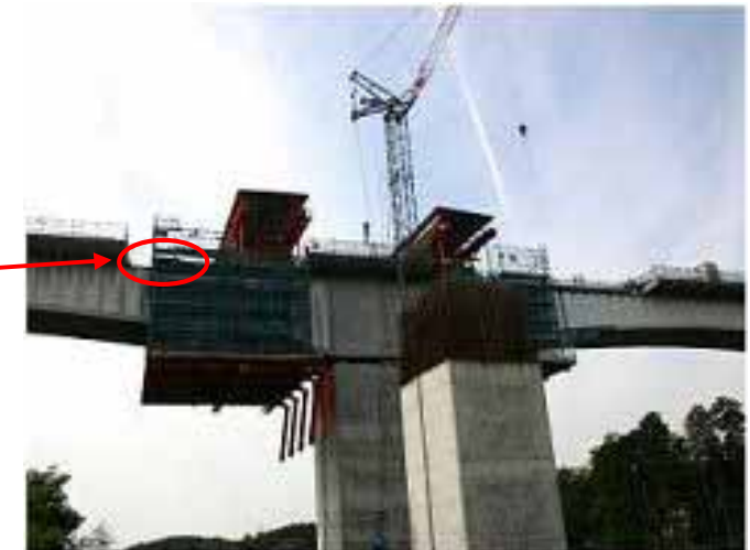
P 9 橋脚基部移動作業車据付後
