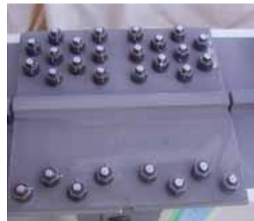
レール設置状況
