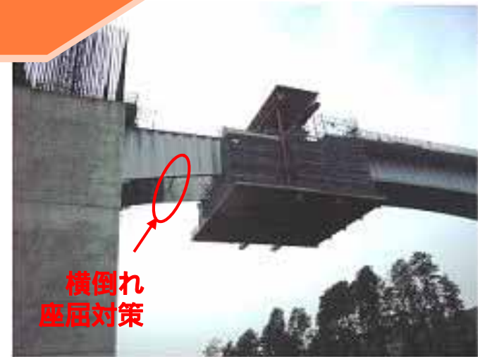
P 8 - P 9 橋脚波形ウェブ閉合後
