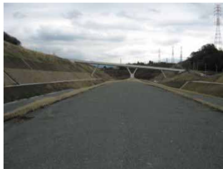
盛土完成状況
