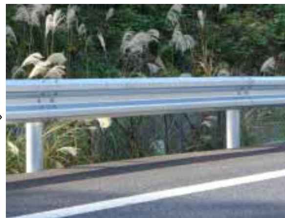
設置 現場へ運搬後、設置
