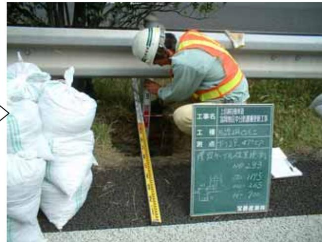
試掘による光ケーブルの位置確認
