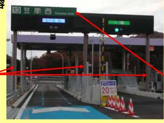
構造的に一体的なデザインとするためにガントリーと同じ幅とし**長くした名称板**
