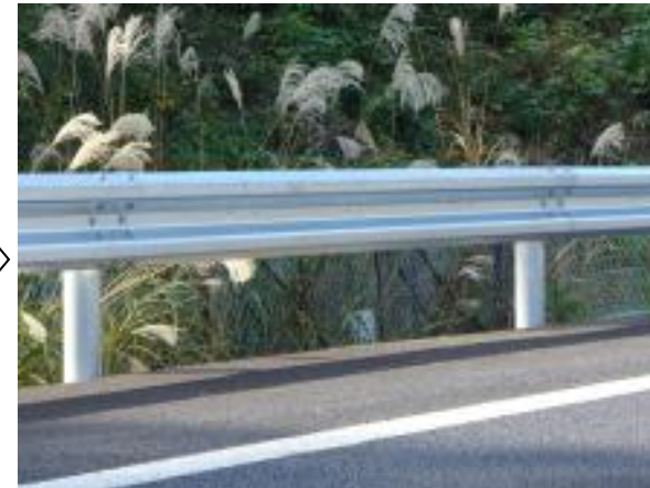
⑤設置 現場へ運搬後、設置
