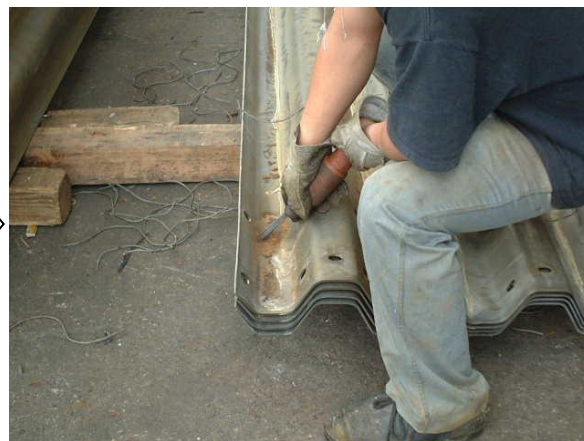
②ガードレール清掃 部材の清掃及び研掃を行う
