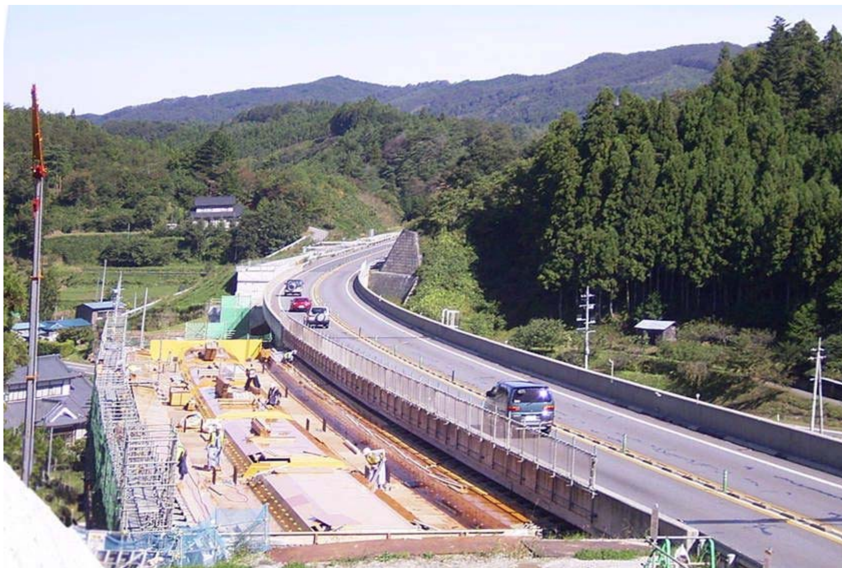
磐越自動車道 寺内橋
