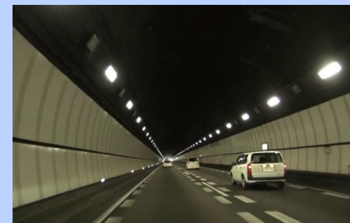
照明状況 (対称照明方式)
