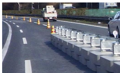
ラバーコーンと置き式基礎ガードレール設置状況(イメージ)
