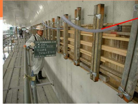
側壁部間詰型枠設置状況
