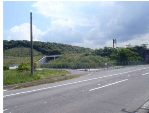
写真① (下り線側)
