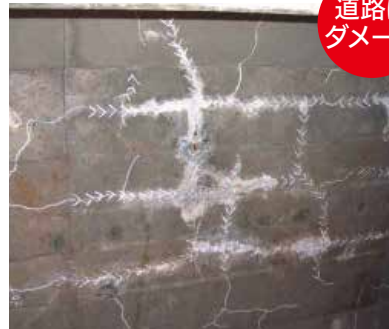
橋（床版）の損傷事例
