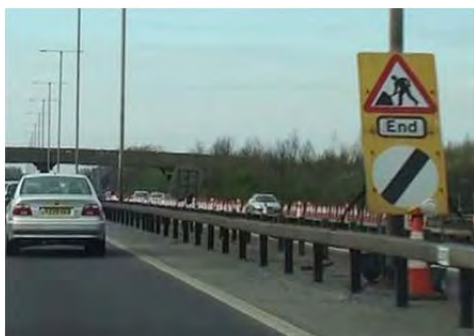
写真 2－10 工事区間終了
