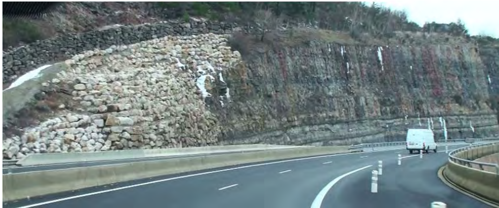
写真左側は土嚢ではなく石積み
