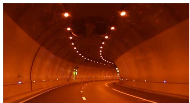
南行き（下り勾配）にのみジェットファンあり (数箇所)
