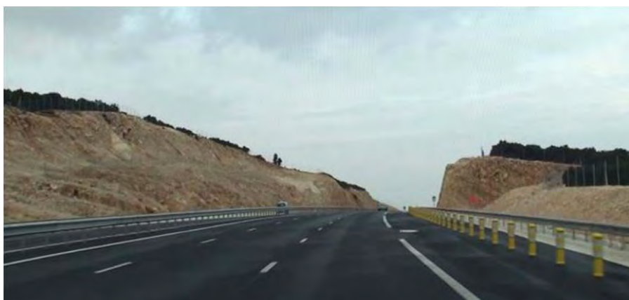
A9 では緑化されていない区間が多い。流れ盤は緩勾配、受け盤は直角に近い
