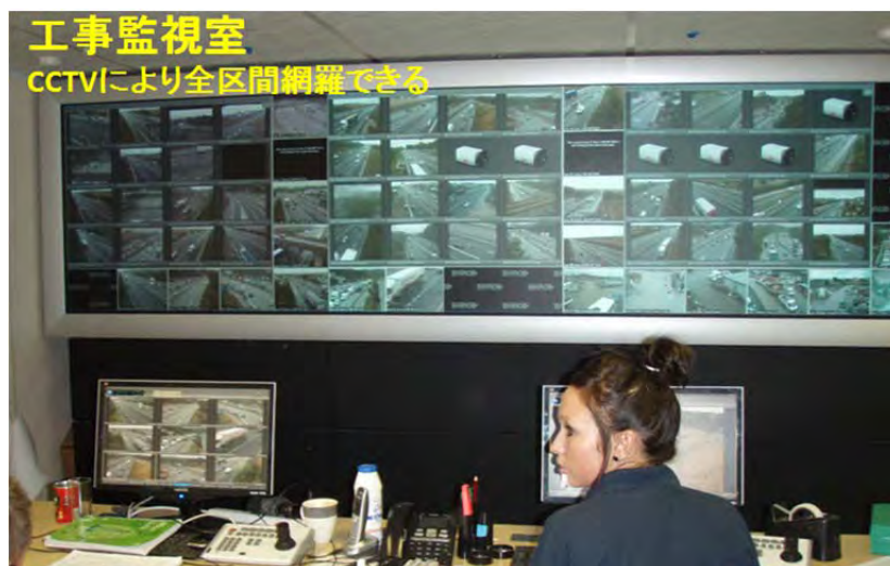
写真 2 - 6 工事現場及び工事監視室の状況
