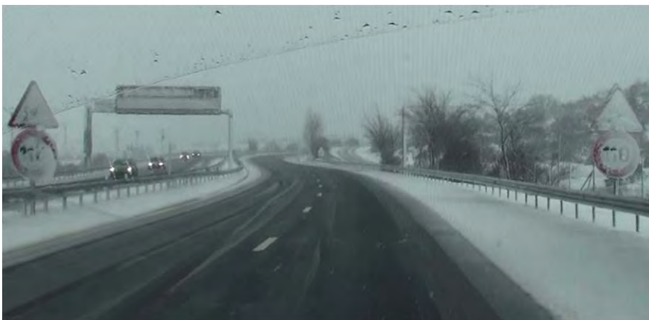
黒く見える車線は3車線のうちの走行側2車線。追い越し車線は完全に積雪
