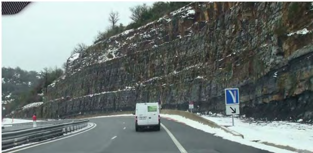
岩盤の段切り
