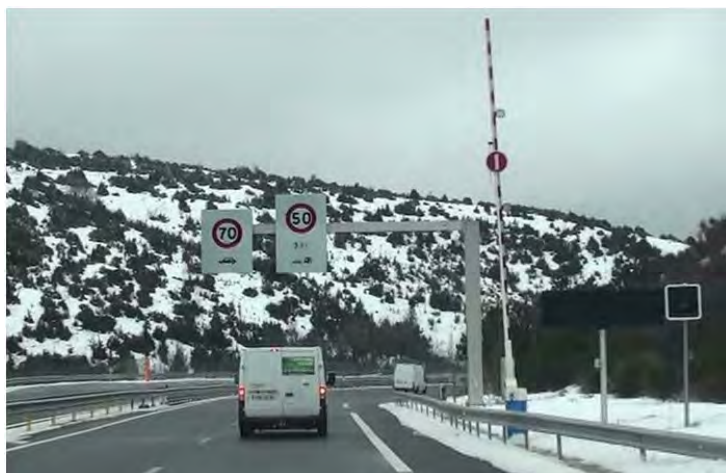
一般車 70km/h に規制されている区間。通行止め用ゲートもある
