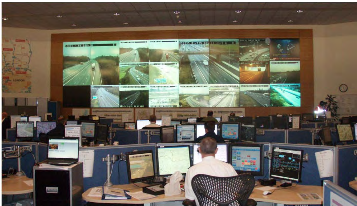
写真 2 - 1 東地区地域管制センター内部
